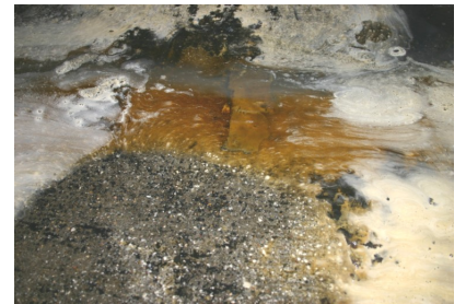
micro dérochage acide actionnant la remontée des corps gras du type huile de vidange, incrustés dans les dalles en ciment
